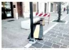
La panchina danneggiata in via Battisti
