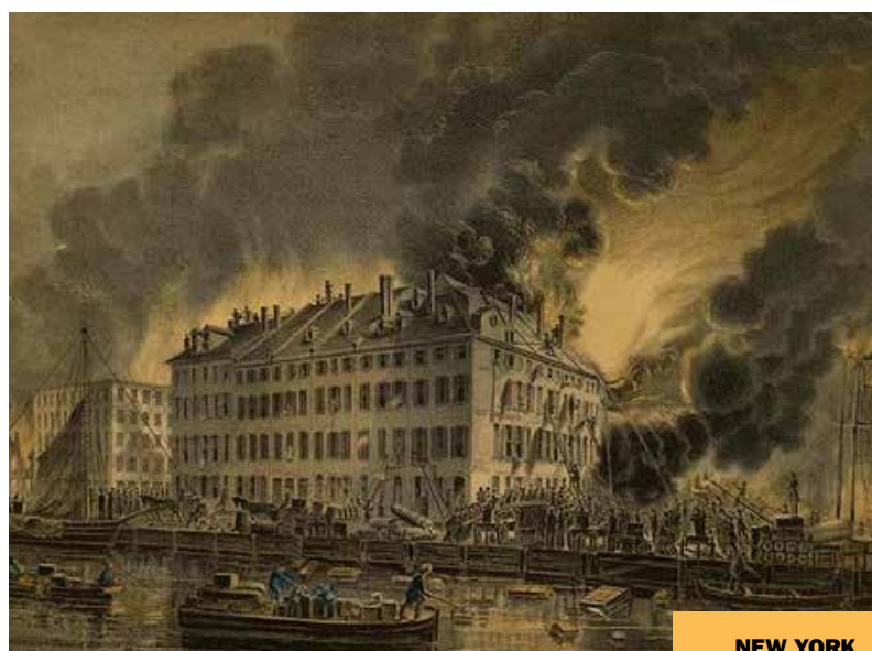
NEW YORK IN ALTO, LA HOFFMAN HOUSE. QUI SOPRA, L'INCENDIO DEL 1835.
